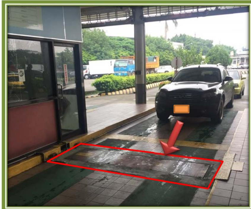
圖 4-2 受檢車輛駛入軸磅上，重量大於 250kg，啟動車牌辨識信號
